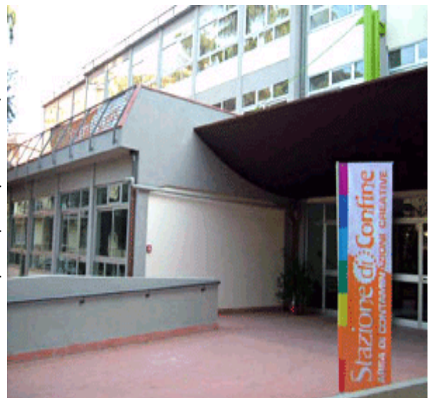
Via Attavante: l'ingresso della STAZione di Confine
